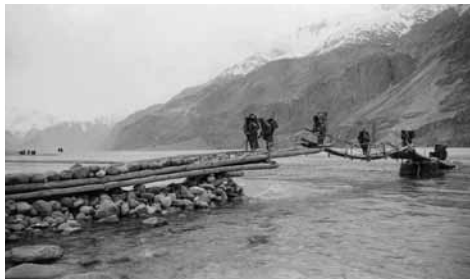
Brücke über den Shayok
