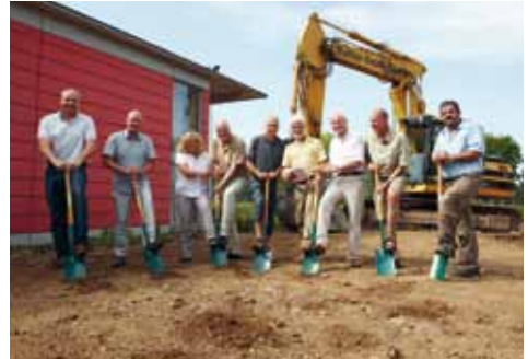
Erster Spatenstich 23. August
