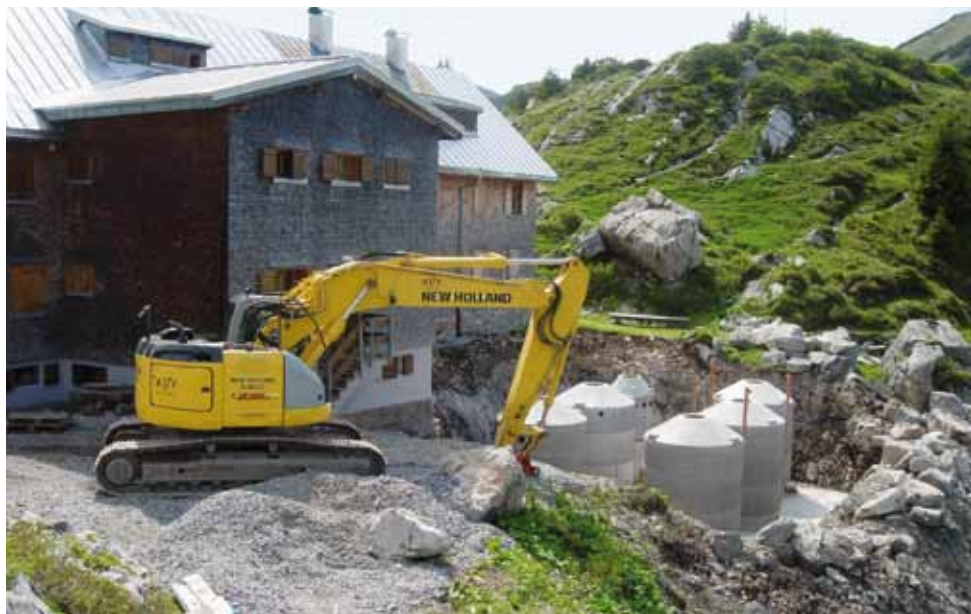
Bau der Kläranlage
