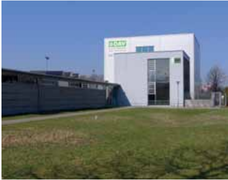
Das neue Sektionshaus
